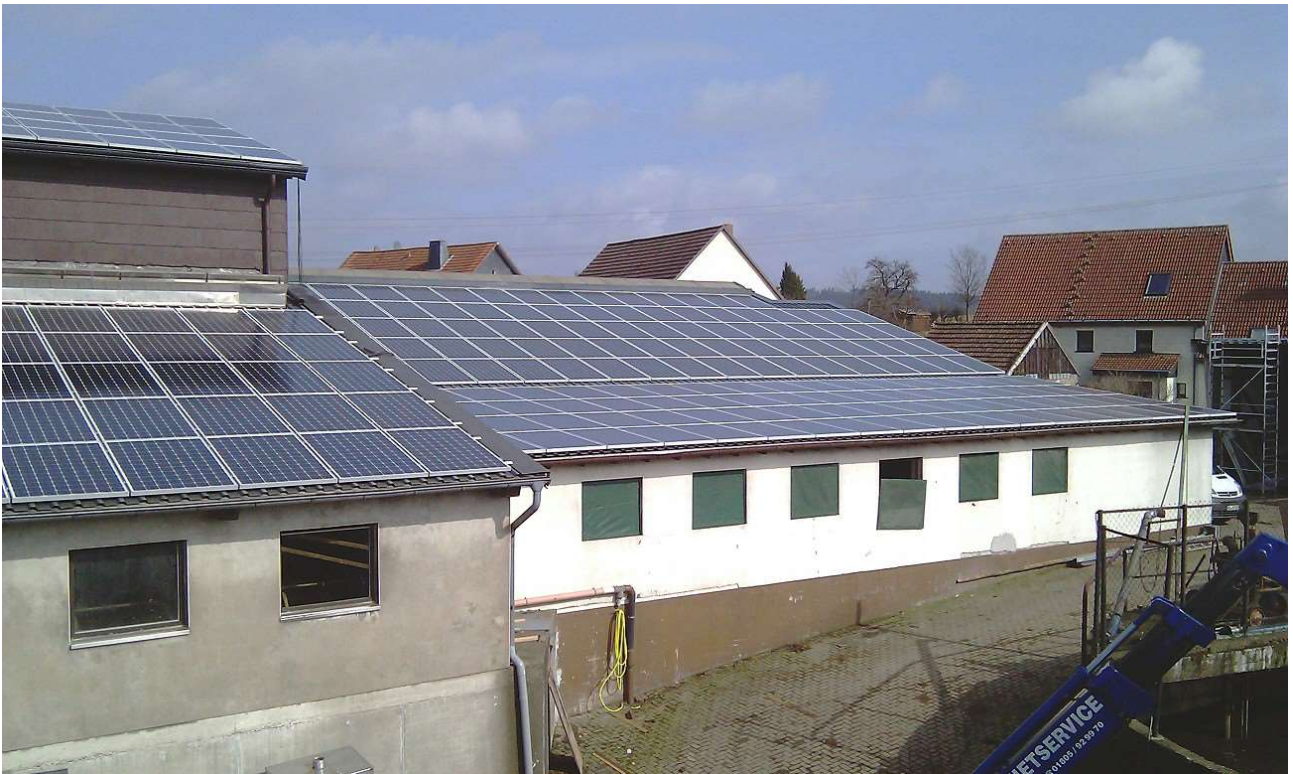
193kwp auf landwirtschaftlichem Betrieb mit Viehwirtschaft, Melkstand und Schlachtereie verteilt auf 15 Dachflächen Bauer Schriever, Vorderster Berg 1 - 58566 Kierspe
