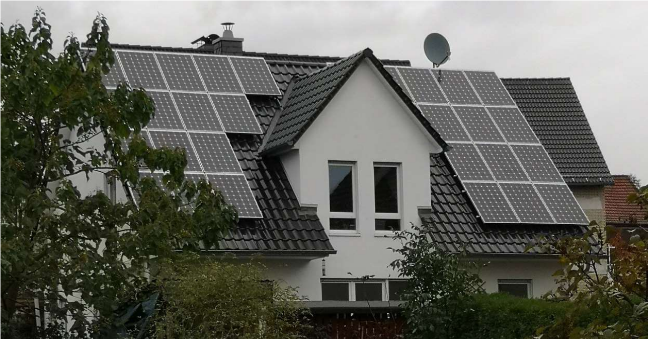
8kwp Aleo Solar mit dem Hauskraftwerk von E3/DC für dieses Einfamilienhaus mit Wärmepumpe. (2014)
